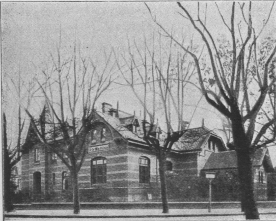
Abb. 545. Erste Warteschule, Ansicht. Architekt Julius Faulwasser.
