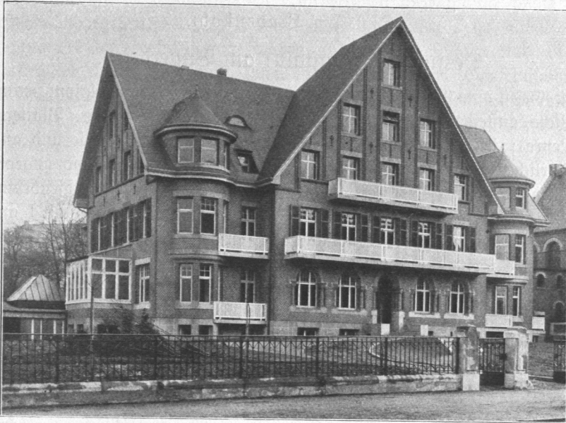
Abb. 502. Krankenhaus Jerusalem, Ansicht.
