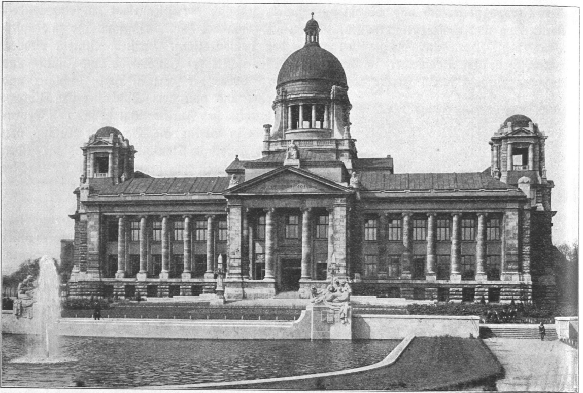
Abb. 178. Oberlandesgerichtsgebäude, Vorderansicht am Sievekingplatz.
