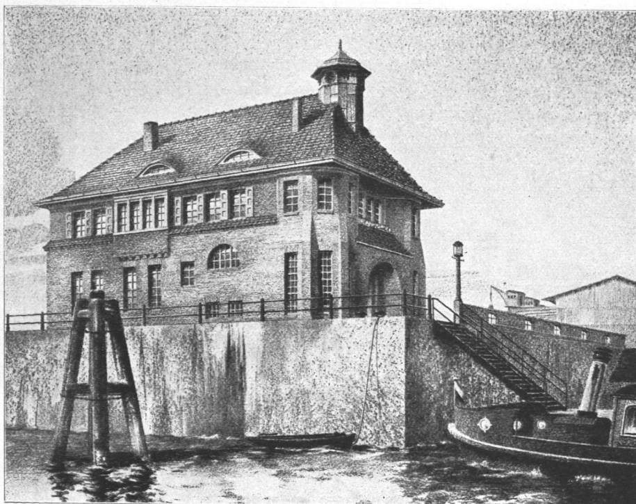
Abb. 389. Feuerwache Steinwärder-Waltershof, Ansicht.
