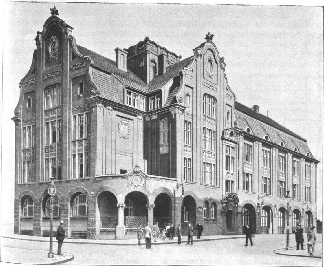
Abb. 386. Feuerwache 2, Admiraltätsstraße, Ansicht.
