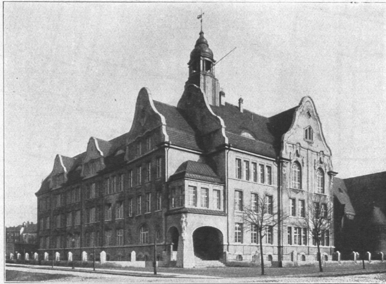
Abb. 286. Höhere Mädchenschule Hansastraße, Ansicht. Entwurf: Bauinspektor Dr. Ing. Erbe. Ausführung: Bauinspektor Schmidt, Baumeister Keith.
