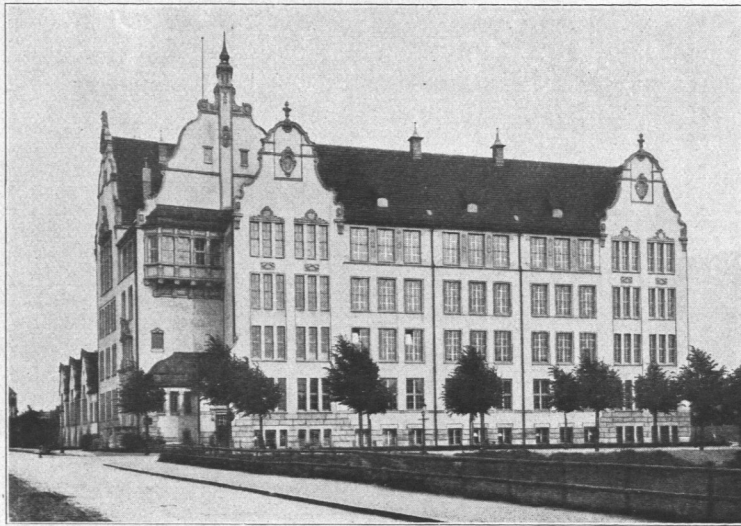
Abb. 275. Realschule Osterbeckstraße, Ansicht.
