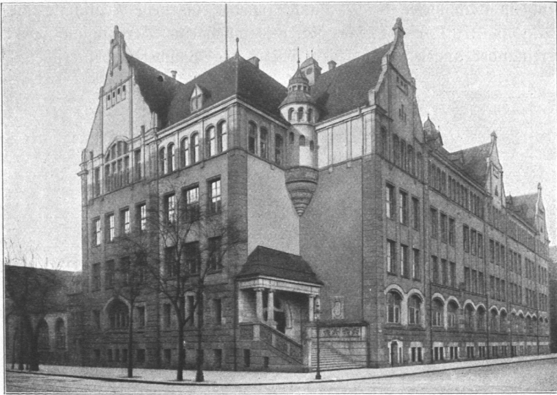
Abb. 273. Realschule Bülastraße, Ansicht.
