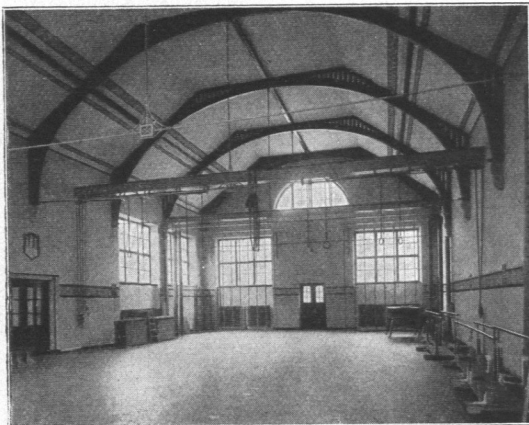
Abb. 249. Volksschule Schwenckestraße, Turnhalle.
