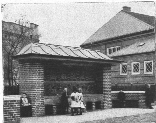
Abb. 251. Volksschule von Effenstraße, Trinkbrunnen.
