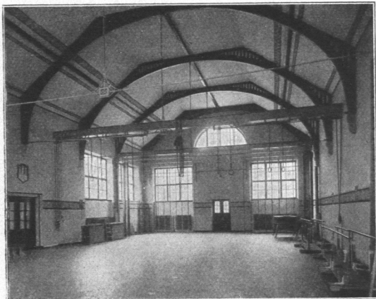
Abb. 249. Volksschule Schwenckestraße, Turnhalle.
