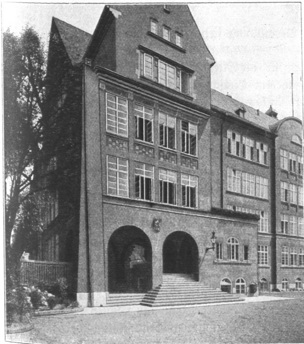
Abb. 209. Volksschule Telemannstraße, Ansicht. Entwurf: Bauinspektor Dr. Ing. Erbe. Ausführung: Bauinspektor Schmidt.
