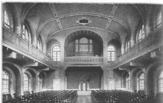
Abb. 154. Gemeindehaus in Eilbeck, Innenansicht, Saal.
