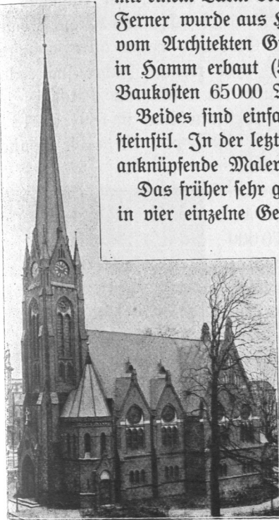
Abb. 82. Markus-Kirche in Hoheluft, Ansicht.
