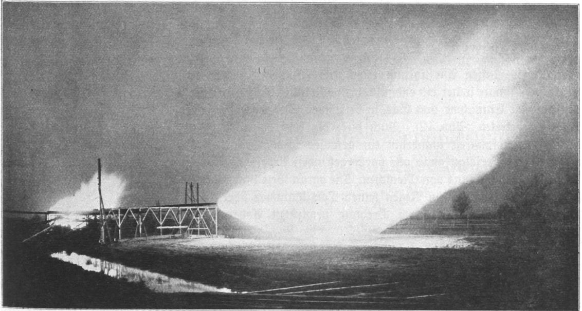
Abb. 9. Bohrstätte bei Nacht nach Verlegung der seitlichen Gasausströmungen und Verschuß der axialen Ausströmung.
