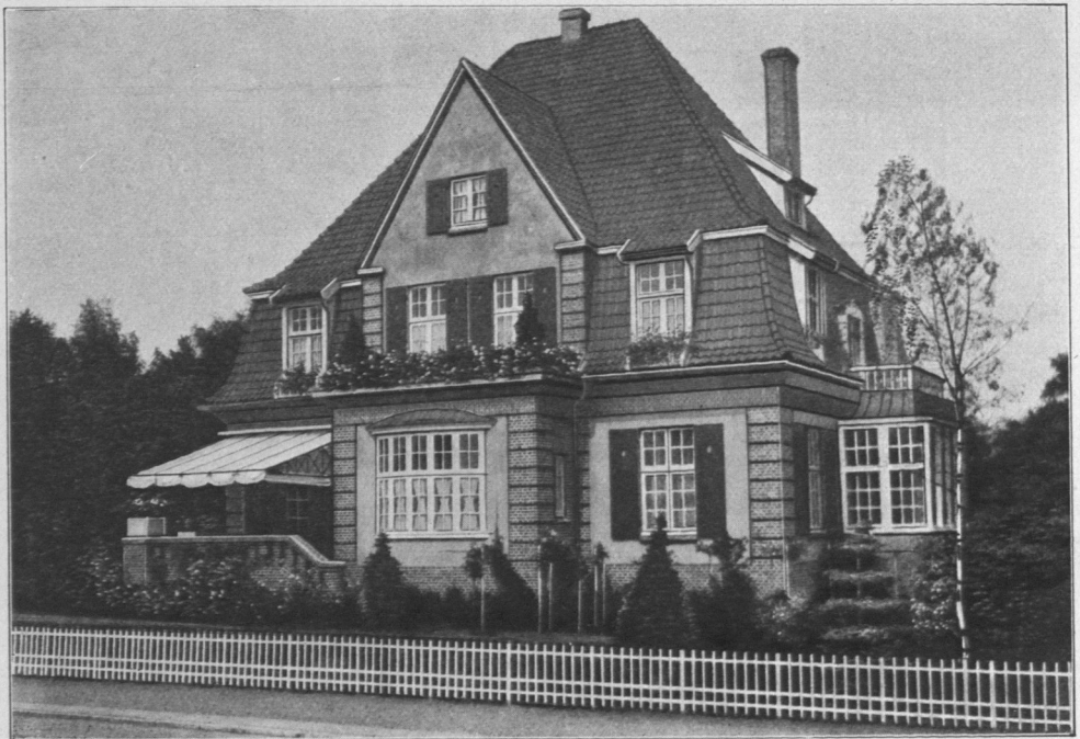
Abb. 1103. Landhaus Lindhorst, Hochkamp, erbaut 1910 durch Architekt Albert Lindhorst. Baukosten 54000 Mark.
