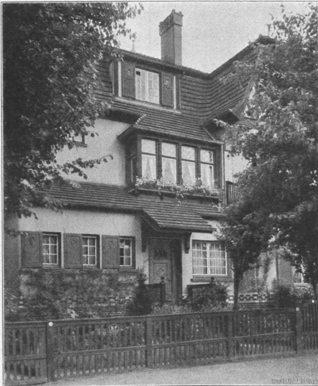
Abb. 1012 (s. auch Abb. 1014). Haus Dr. Brandis, Leinpfad 68, erbaut 1902 durch die Architekten W. und R. Rzekonski, B. D. U. Baukosten 55000 Mark, für das Kubikmeter umbauten Raumes 19 Mark.
