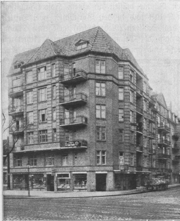
Abb. 973. Erker mit dazwischenliegendem Balkon.
