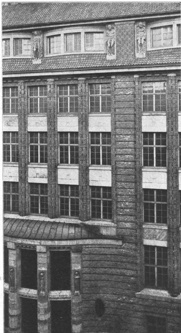
Abb. 320. Hauptgebäude der Technischen Staatslehranstalten, Teilansicht, Mittelbau.
