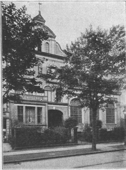
Abb. 145. Uhlenhorster Gemeindehaus, Ansicht.
