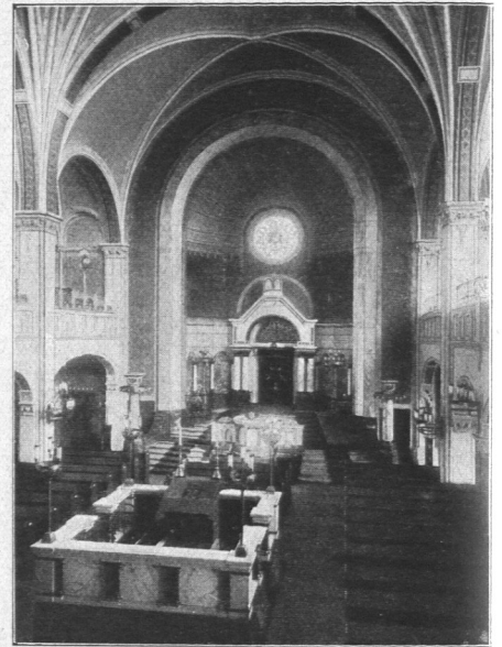
Abb. 140. Neue Synagoge, Innenansicht.
