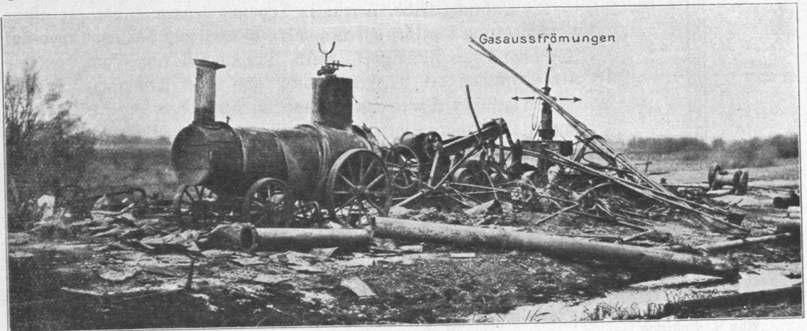
Abb. 7. Bohrstätte bei Tage nach Zerstörung des Bohrturmes und des Maschinenschuppens.
