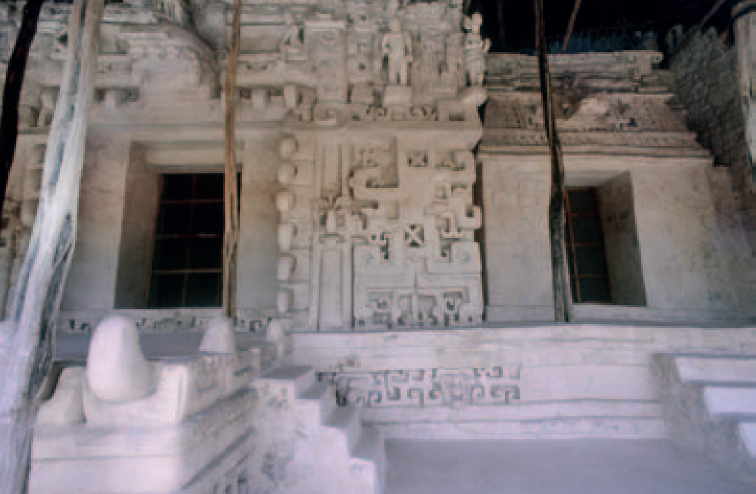
Abb. 151 Der rechte Nebenbau und ein Großteil des Hauptbauwerkes mit Monsterracheneingang in Ek Balam . Die Mauern, welche die Sicht auf den Racheneingang zum Teil verstellten, sind entfernt worden. Ihren ehemaligen Verlauf kann man heute in den sichtbar gelassenen Fundamentstreifen erkennen. Foto: Hasso Hohmann 2004
