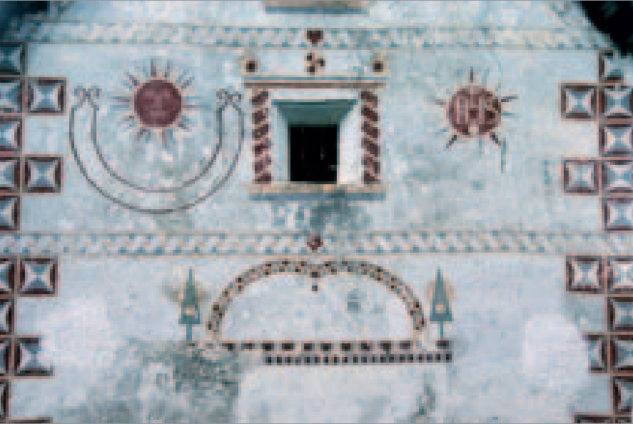
Abb. 30 Detail der Ostfassade des Schüttkastens in Pichlern mit dem Gesicht. Foto: Hasso Hohmann 2004
