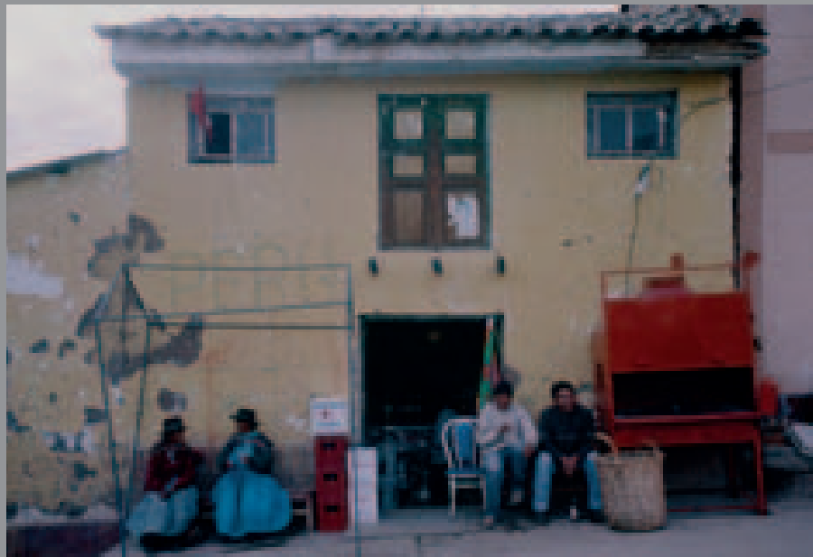
Abb. 271 Bei diesem Haus aus Vilcas Huaman gibt es auch einen Balkon mit Tür, der quasi die Nase des Gesichtes in der Fassade ergibt. Foto: Hasso Hohmann 2004
