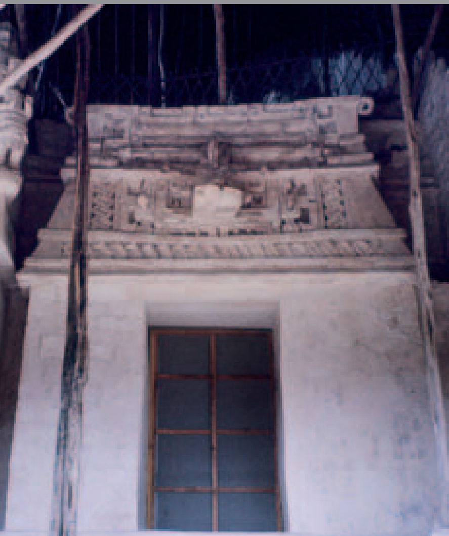
Abb. 155 Der rechte der zwei Nebenbauten neben dem Hauptgebäude mit dem Racheneingang von Ek Balam . Das Bild zeigt auch gut den Übergang vom Hauptbauwerk links zum Nebengebäude rechts durch einen zurückweichenden Schlitz, sodass es hier zu keiner Kollision der zwei Fassaden kommt. Das Hauptgebäude stellt einen typischen spätklassischen Tempel aus Stein mit Gewölbezone dar, das andere ist die Darstellung eines zeitgleichen Bauwerks aus vergänglichem Material, das hier aber in Stein und Stuck ausgeführt wurde. Foto: Hasso Hohmann 2004
