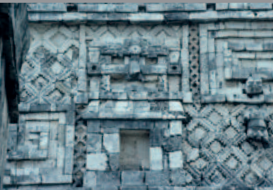
Abb. 165 Dieses Relief ist eines von einer Serie von ähnlichen Architekturdarstellungen in der Fassade des westlichen Traktes im "Nonnenviereck", dem Bauwerk 14 von Uxmal , Yucatán, Mexiko. Sie alle finden sich auf Höhe der Gewölbezone und stellen Tempel aus vergänglichem Material dar, die mit einem Kraggiebelfußwalmdach ausgestattet waren. Die Dächer waren mit Palmblättern gedeckt und trugen oben große Masken. Derartige Bauten aus vergänglichem Material haben sich in Reliefs, Graffiti, dreidimensionalen Modellen und Wandmalereien erhalten. Foto: Hasso Hohmann 1998
