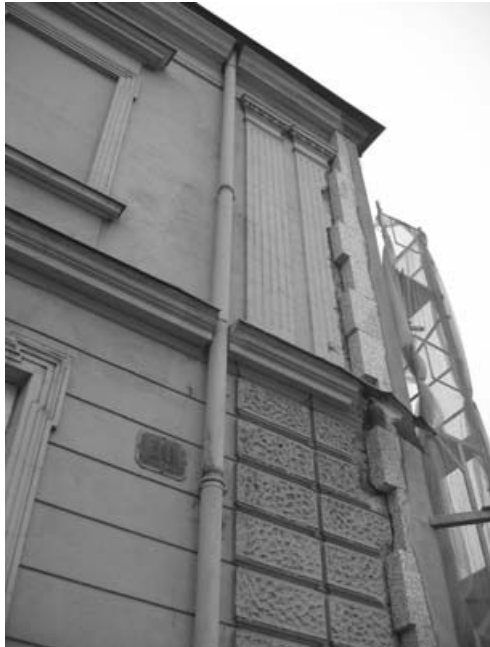
Abb. 1 und 2: Zerstörung und Imitation der originalen Fassaden durch Wärmedämmsysteme sind keine denkmalverträglichen Maßnahmen
