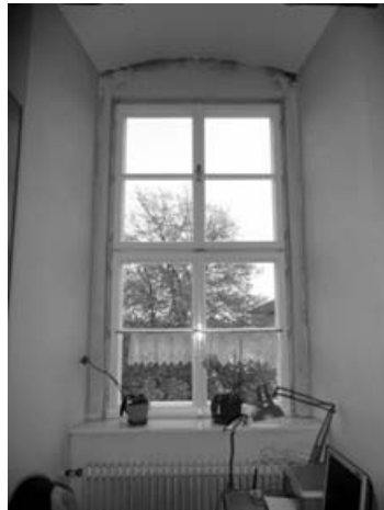
Abb. 8: Natursteingewände und Einfachfenster in mittelalterlichen Gebäuden
