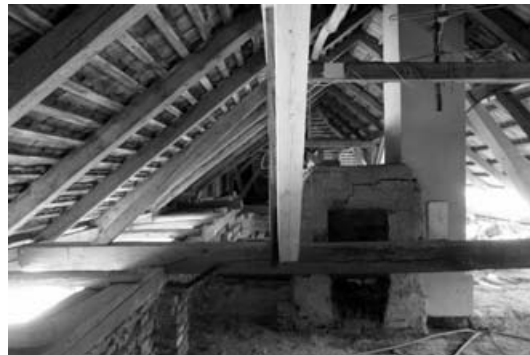
Abb. 11 und 12: Oberste Geschoßdecke eines ehemaligen Bauernhauses mit Selch, Kamin, einzelnen Überzügen und Höhenversprüngen
