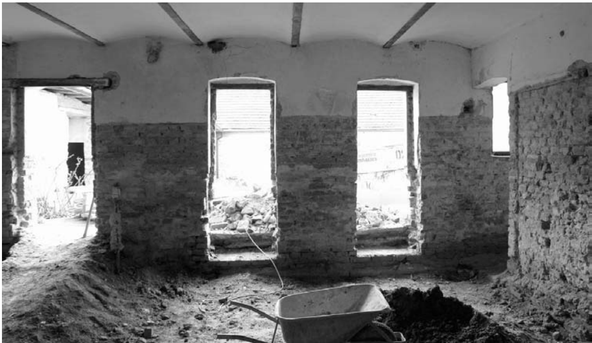
Abb. 15: Aushub für eine Bodendämmung
