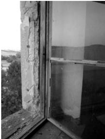
Abb. 8: Natursteingewände und Einfachfenster in mittelalterlichen Gebäuden
