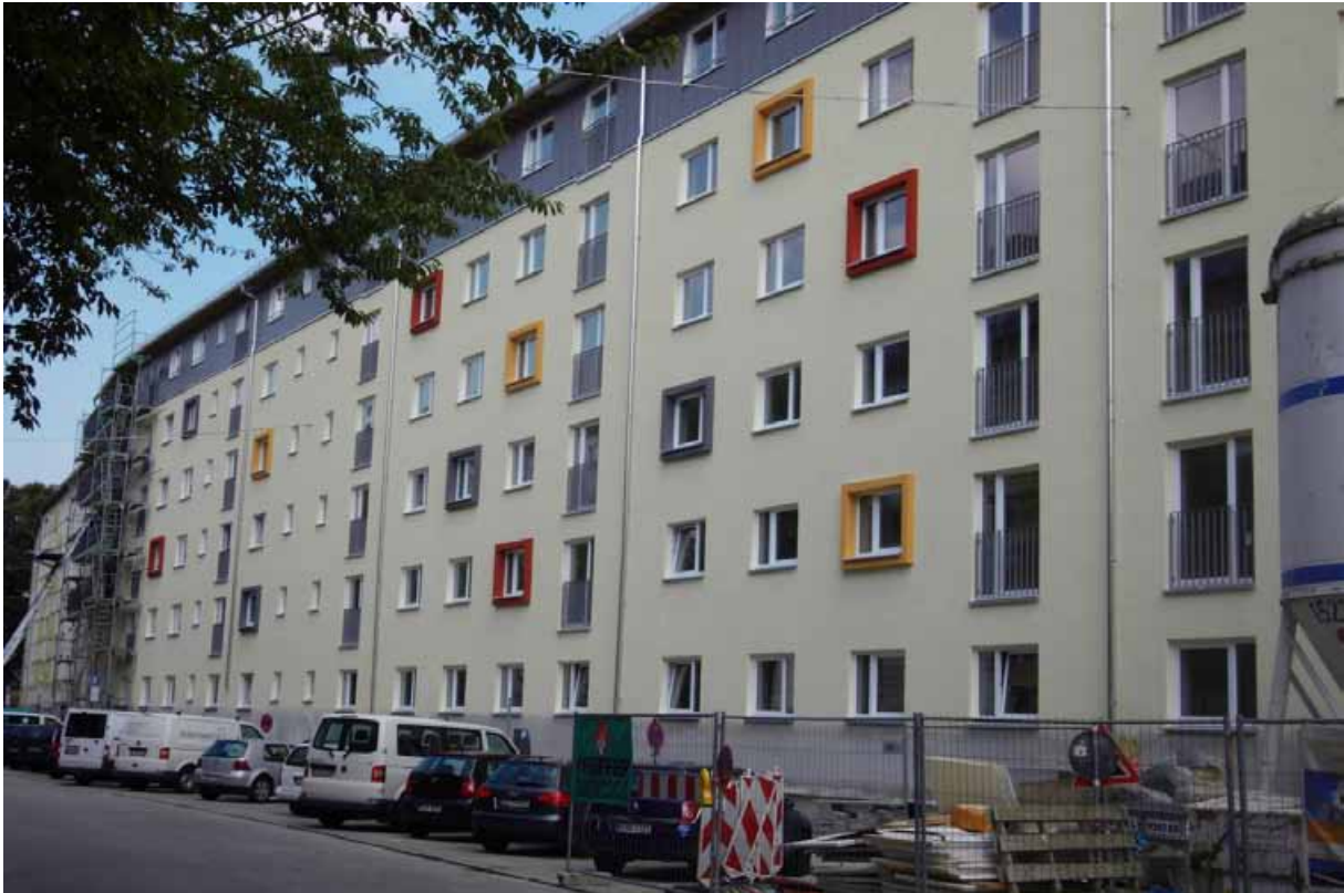
Bild 5: Westfassade des Demonstrationsvorhabens in München mit einem platzsparenden Vakuum-Wärmedämmverbundsystem.
