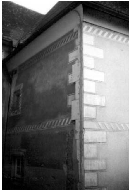
Abb. 1 und 2: Zerstörung und Imitation der originalen Fassaden durch Wärmedämmsysteme sind keine denkmalverträglichen Maßnahmen
