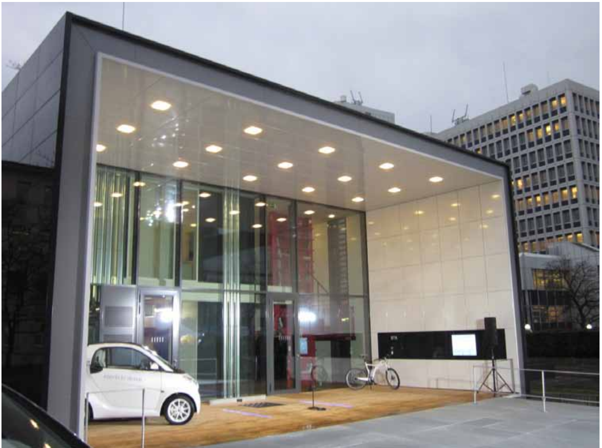
Bild 4: Nordansicht des Pilotgebäudes der BMVBS-Initiative „Effizienzhaus-Plus mit E-Mobilität“ in Berlin.
