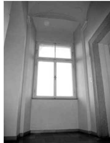
Abb. 9: Fassadenbündiges Verbundfenster mit nachträglicher Dichtung und plötzlichem Schimmel
