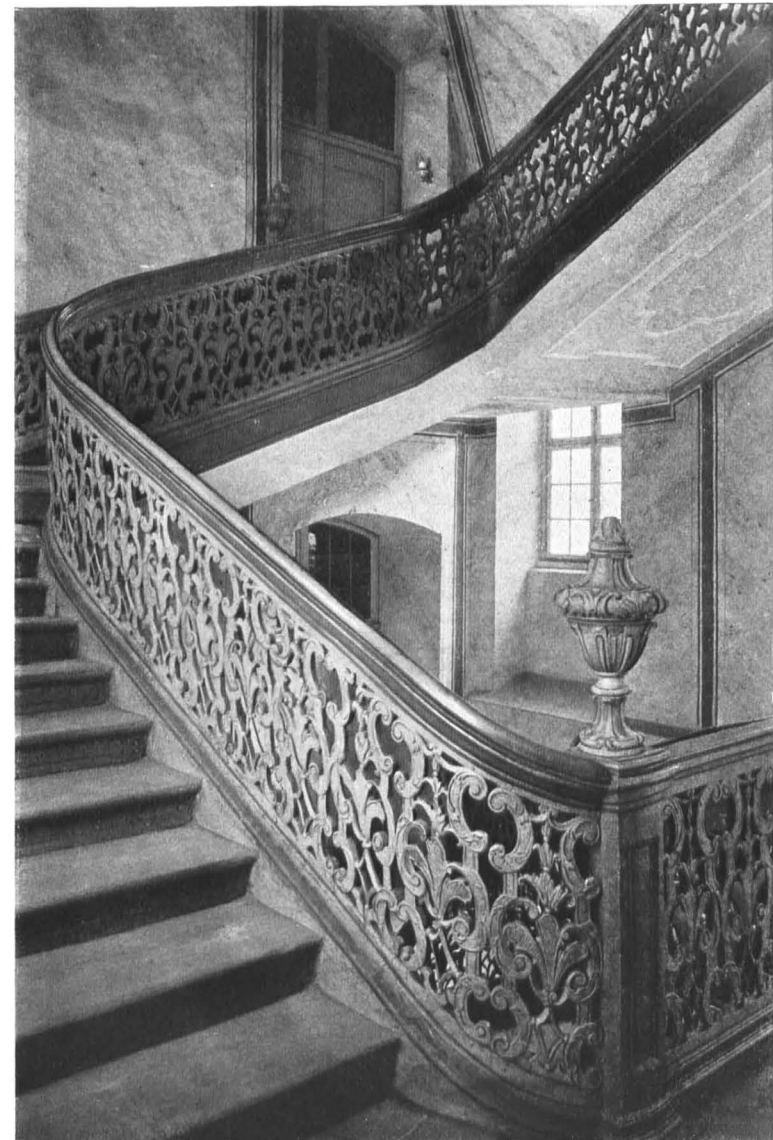
Bamberg. — Treppe im Hause von der Pfordten, Karolinenplatz 1 Unter der Regierung des Fürstbischofs Marquart von Stauffenberg im Anfang des 18. Jahrh. erbaut
