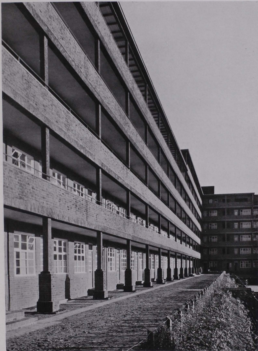
Neue Wohnbauten: Laubenganghaus
