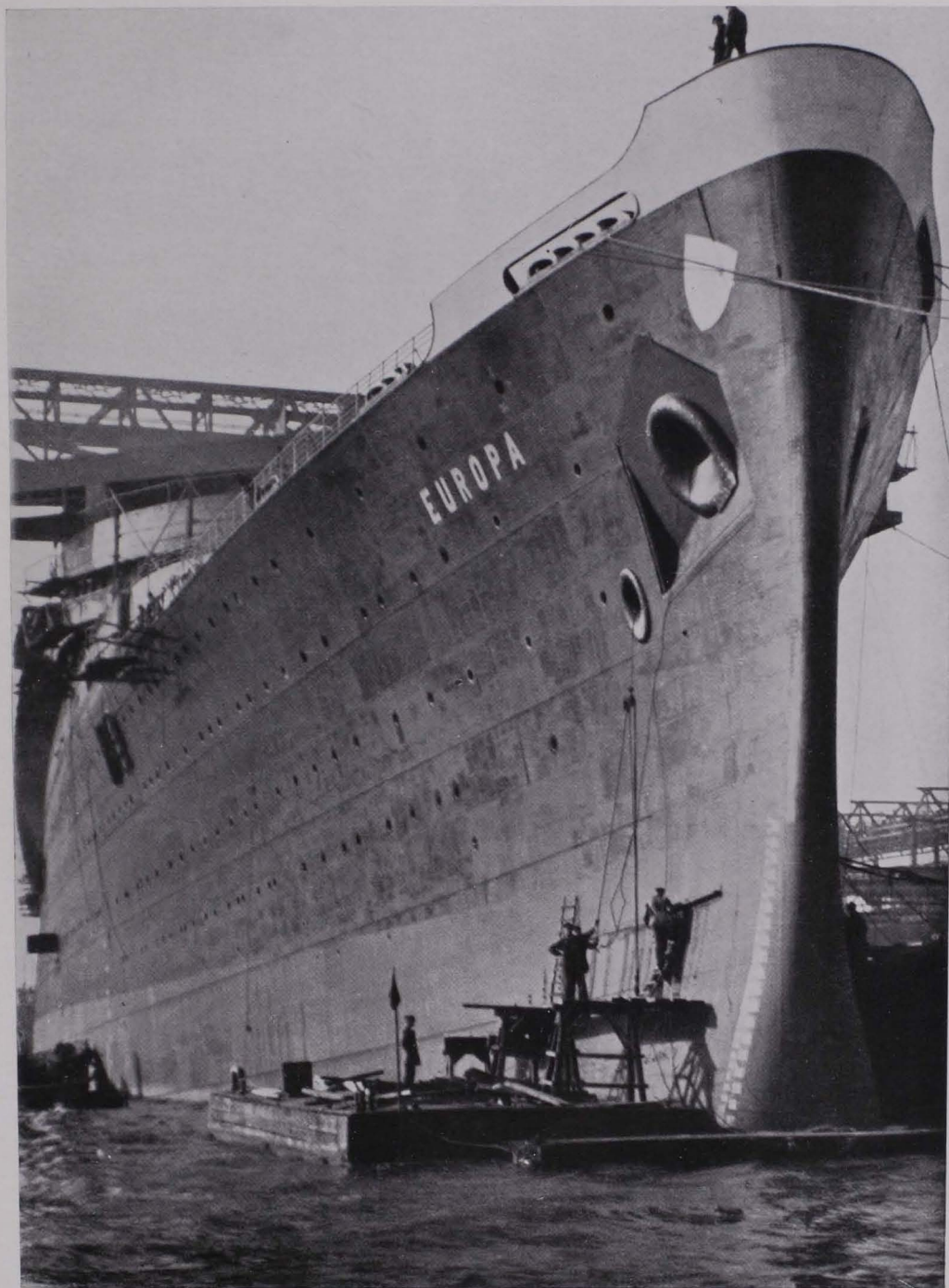
Die „Europa“ im Bau
