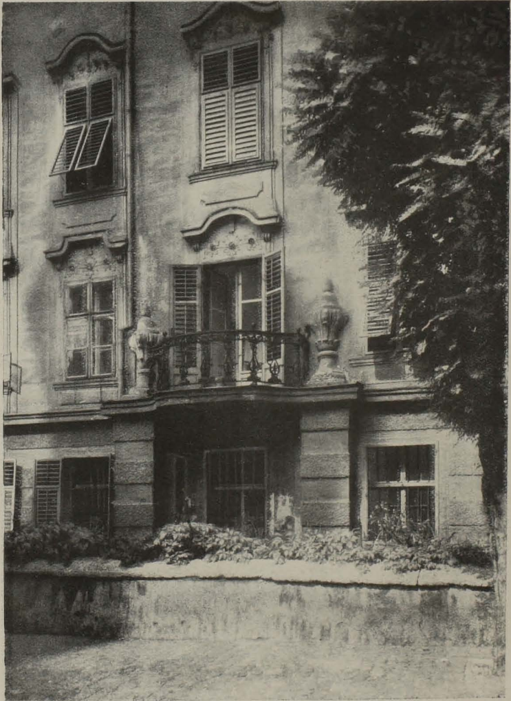
Abb. 28. Damenstift, Teil der Fassade.
