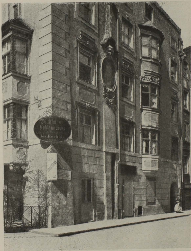
Abb. 16. Das Gumpahaus (Riebachgasse 16).
