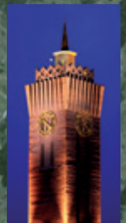
Der 70 Meter hohe Uhrenturm der Maschinenfabrik Schubert & Salzer A.G., heute Wirkbau Textilmaschinenfabrik GmbH; eines der Industriedenkmäler.
