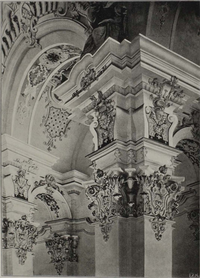
Pfeiler und Kapitele in der Kirche von Steinhäusen.
