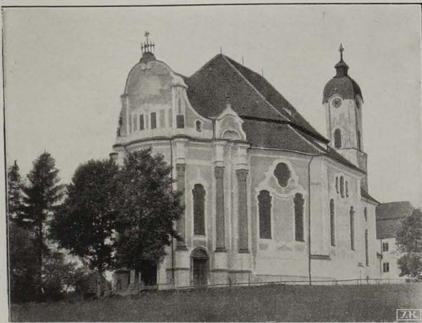
2. Außenansicht der Wallfahrtskirche in Wies. 1746—1754.
