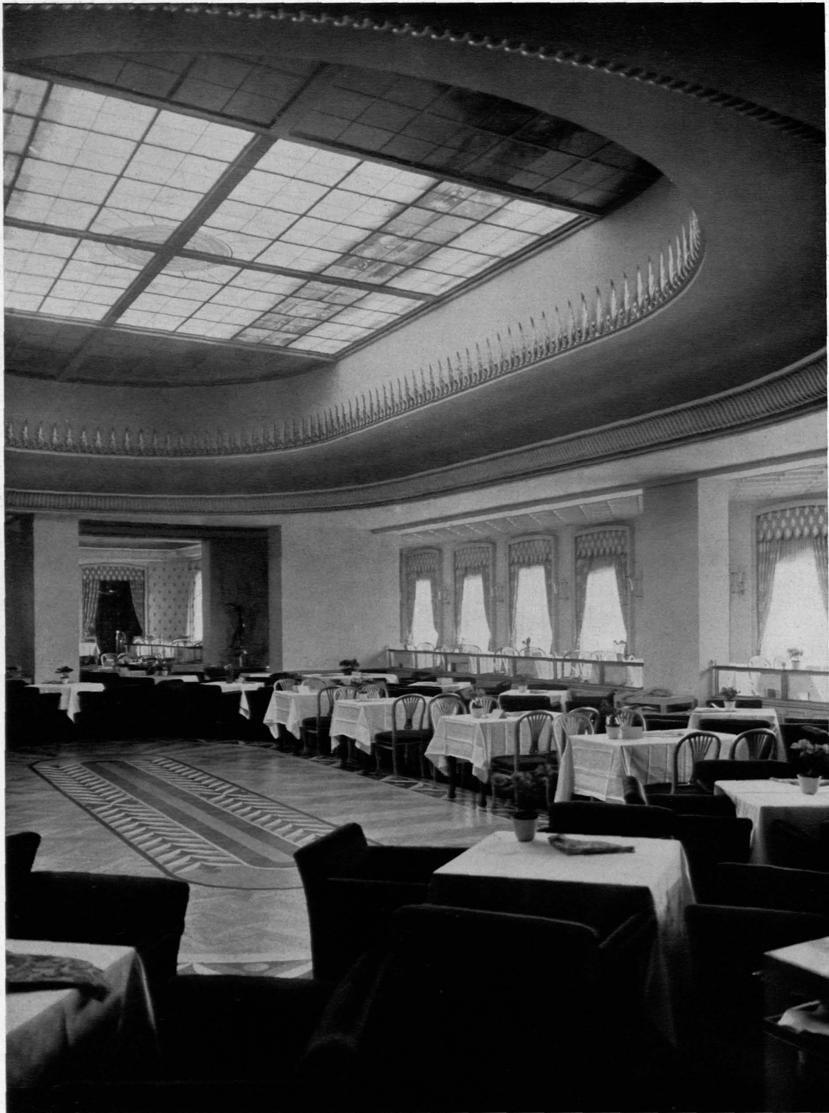
Der große Tanzsaal im Weinrestaurant „Frasquita“ in Berlin. Architekt Fritz Gaulke. Über dem Parkett eine Glasdecke, die als Schiebedach ausgebildet ist und an warmen Sommerabenden geöffnet werden kann. Der Tanzsaal ist von Tischreihen, einer Speiseterrasse und an der Stirnseite von Logen umgeben. Die Wände sind weiß, teils Stuck, teils Atlasstoff. Bezüge und Teppichbelag sind rot, die Metallteile vergoldet
