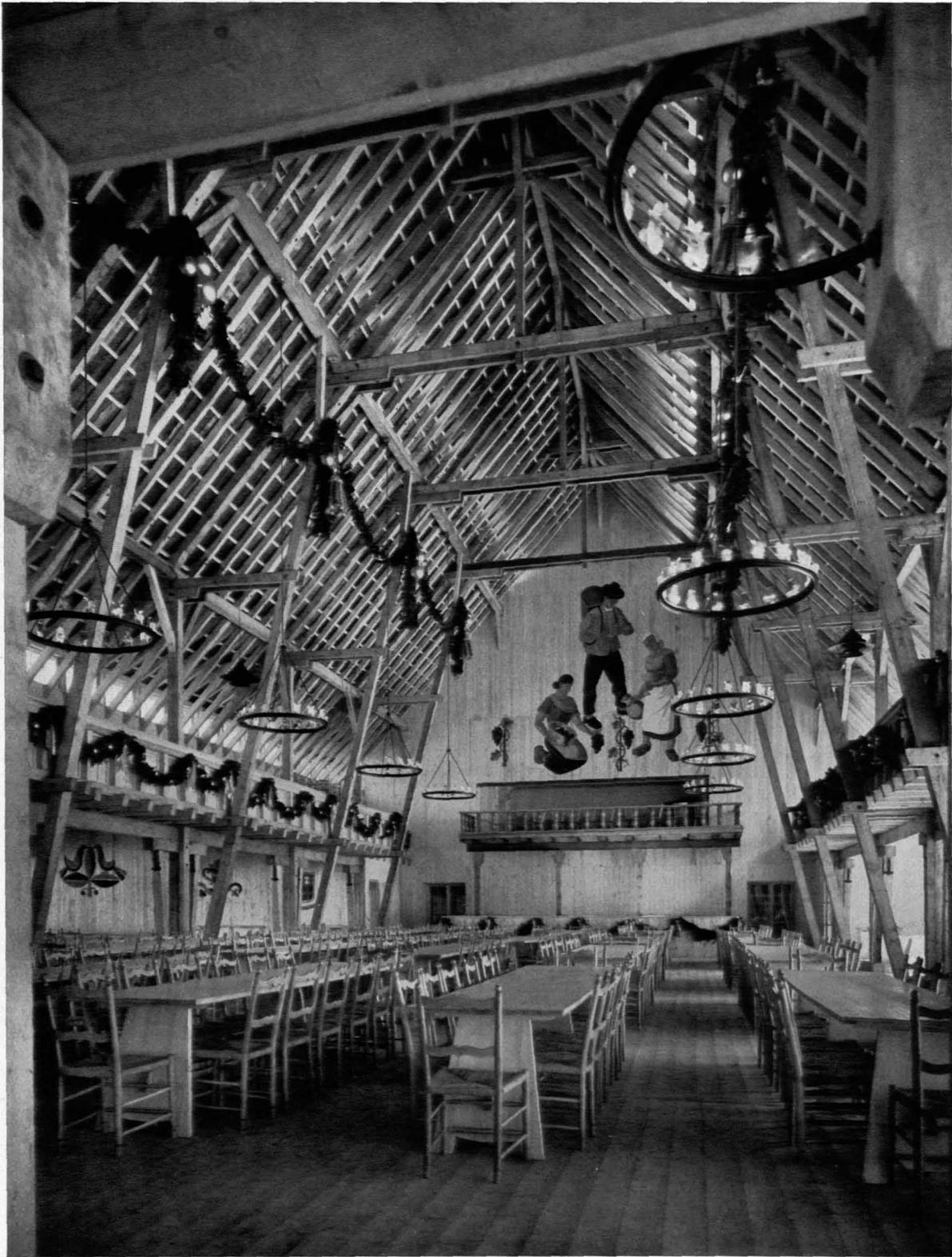
Die Saarpfalzhalle in der KdF.-Stadt. Firsthöhe 14 Meter. Die Ständerkonstruktion in Holz ist sichtbar gelassen. Die Stirnwand über dem Musikbalkon schmückt ein Bild von G. O. Meyer, Nürnberg. Links und rechts die Durchgänge zu den Küchenräumen. Die 1936 zur Olympiade in Berlin errichtete Anlage steht jetzt auf dem Reichsparteitagsgelände in Nürnberg; sie wurde erstellt von der Bauabteilung der DAF. unter Julius Schulte-Frohlinde, Berlin. Riß S. 48
