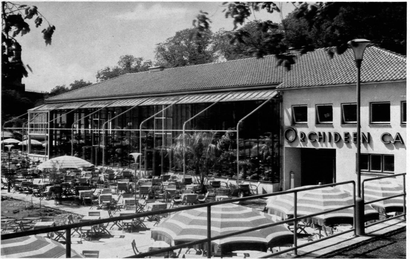
Das Orchideen-Kaffee im ehemaligen zoologischen Garten Hamburgs, Architekt Gustav Meves, Hamburg. Die Südwand, vor welcher am leicht abfallenden Gelände bepflanzte Wasserbecken angeordnet sind, ist zu großen Pflanzenfenstern für tropische Gewächse ausgebildet. Den Sonnen- und Regenschutz der offenen Terrasse übernimmt ein verschiebbares Glasdach zwischen festen Schienen. Grundriß Seite 184
