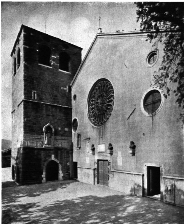
Facciata di S. Giusto. — Façade de S. Giusto.
