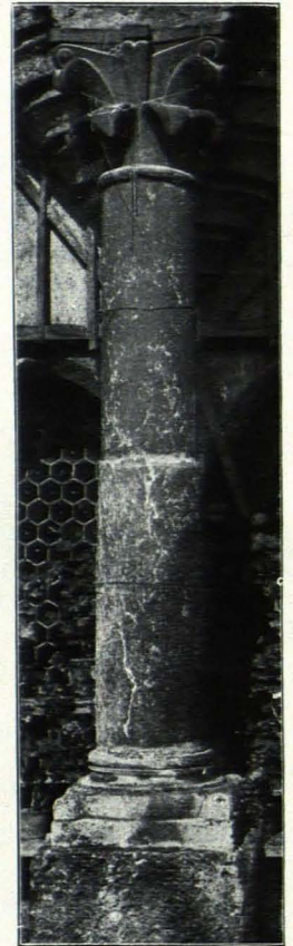
Fig. 244 Stützsäule unter dem Erker (S. 163)
