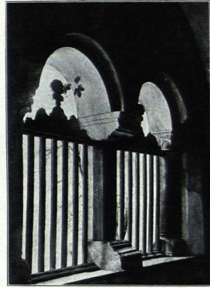
Fig. 236 Kreuzgang, Fensteröffnungen (S. 156)
