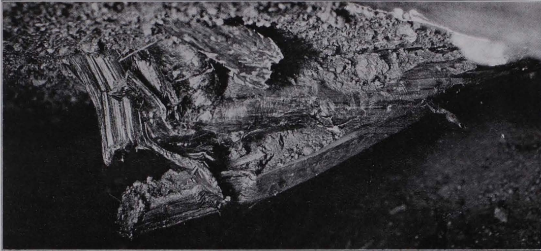
Fig. 54 Stempelzimmerung im Himmel des Platzwerkes. (Nach KYRLE, 1913, Fig. 14.)
