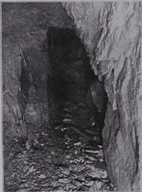
Fig. 15 Verstärkter Verhau, der durch einen südlichen Querschlag des Arthurstollens angefahren wurde. (Nach einer Aufnahme von O. KLOSE.)
