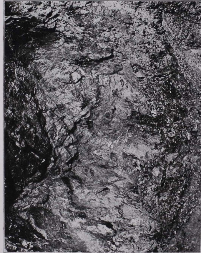
Fig. 33 Altes Ort im Verhaue II des Hermastollens. (Rechts oben die den Berg bedeckende Rußschicht, in der Mitte das plattenförmige oder zackige Wegbrechen des durch Erhitzen und Abkühlen gesprengten Gesteines.)
