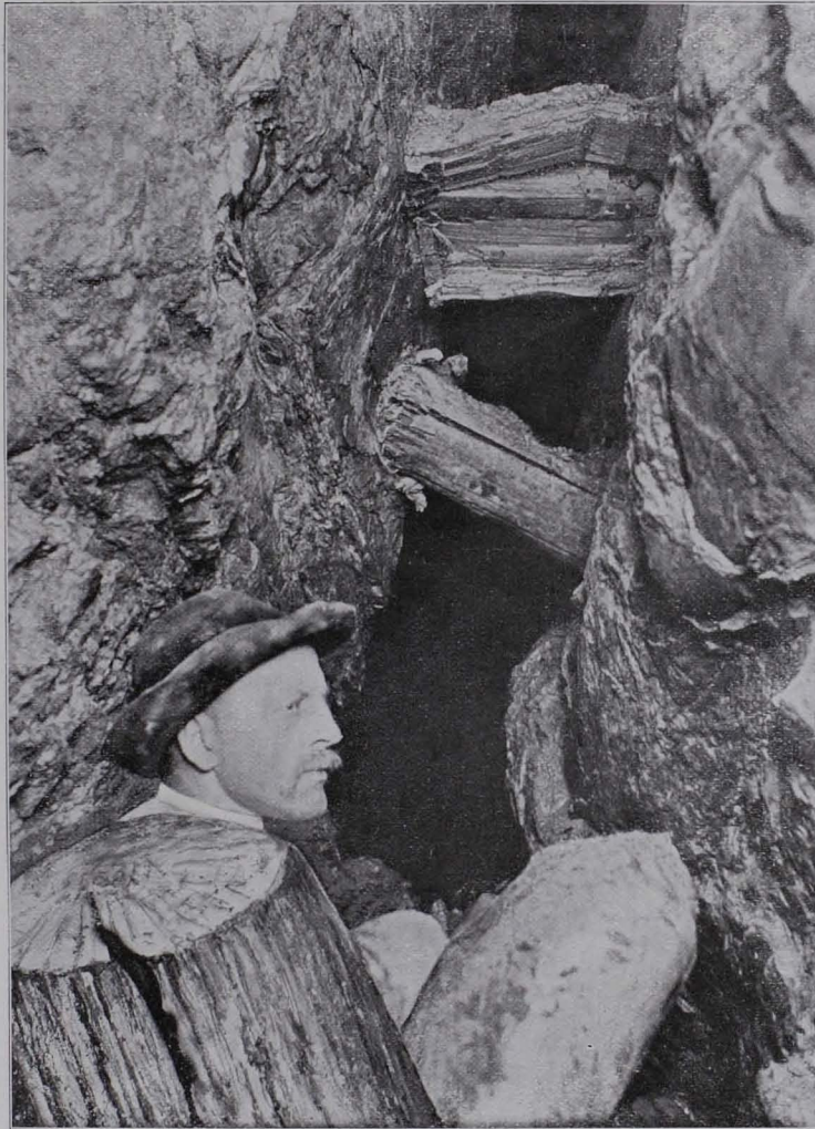
Fig. 19 Leiterähnlich angelegte Stempel des Verhaues im Arthurstollen.
