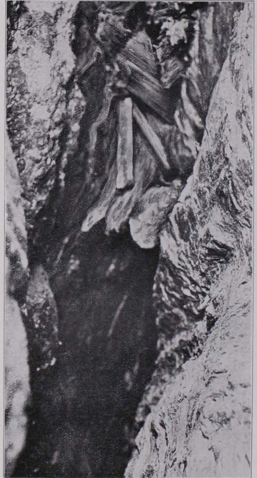
Fig. 18 Im Versturzmateriale eingeschlossene Werkhölzer des Verhaues im Arthurstollen.
