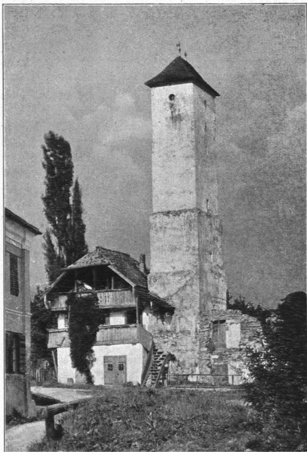
Fig. 578 Oberndorf, Wasserturm (S. 573)
