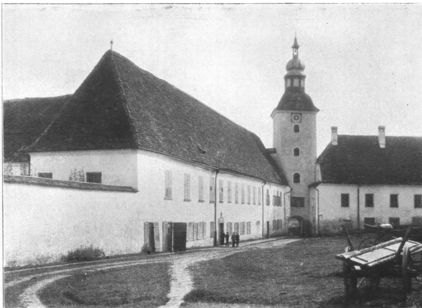
Fig. 518 Michaelbeuern, Wirtschaftshof mit der Prälatur und dem Torturm, Ansicht von Nordosten (S. 526)
