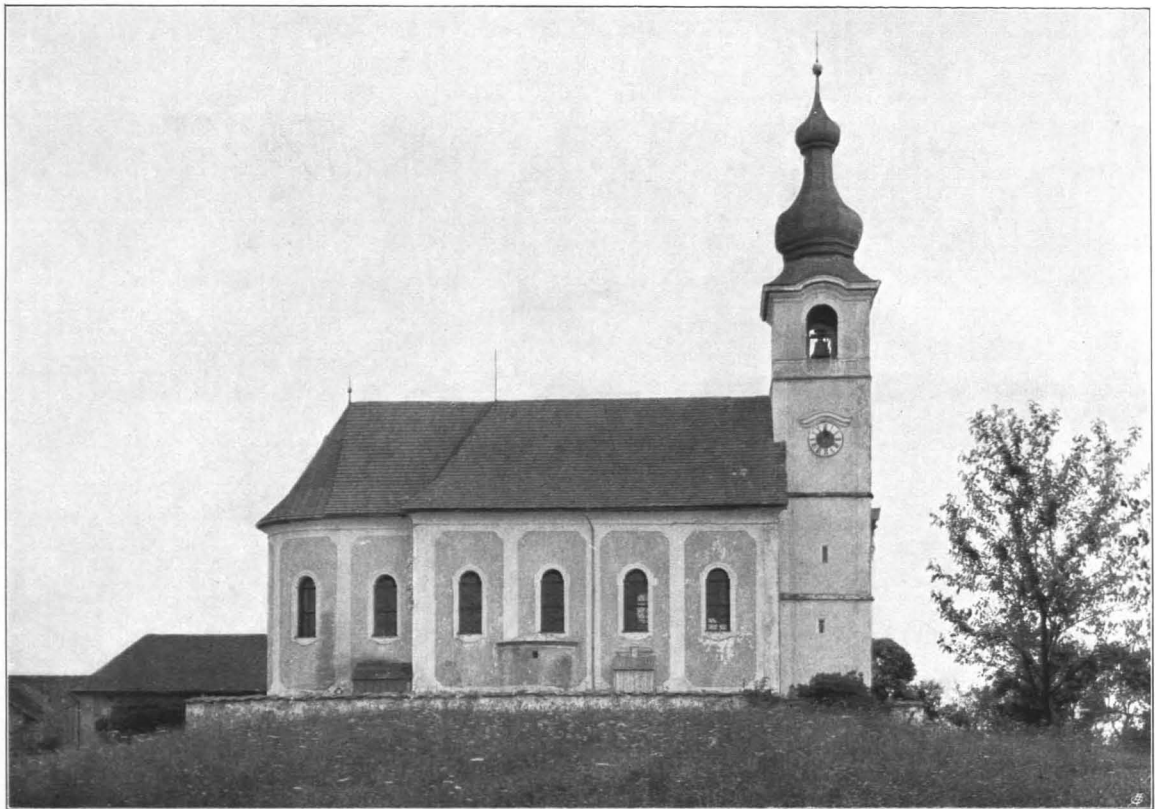
Fig. 433 St. Georgen, Pfarrkirche, Ansicht von Norden (S. 444)
