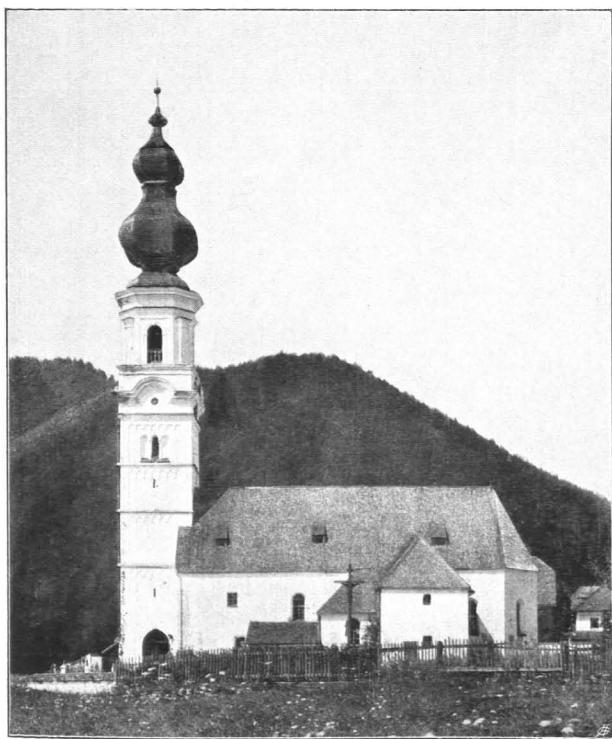
Fig. 203 Faistenau, Pfarrkirche, Ansicht von Süden (S. 205)
