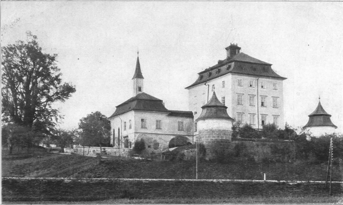
Fig. 112 Schloß Seeburg, Ansicht von Süden (S. 120)
