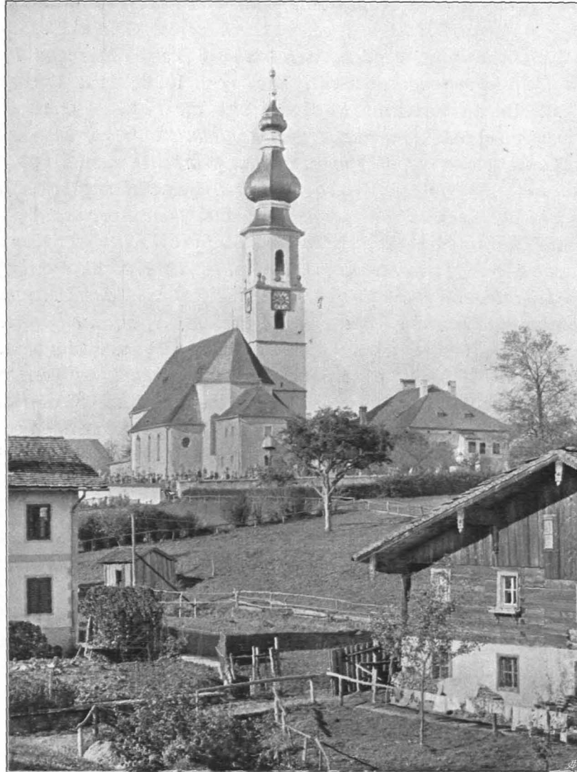
Fig. 75 Köstendorf, Pfarrkirche, Ansicht von Südosten (S. 84)
