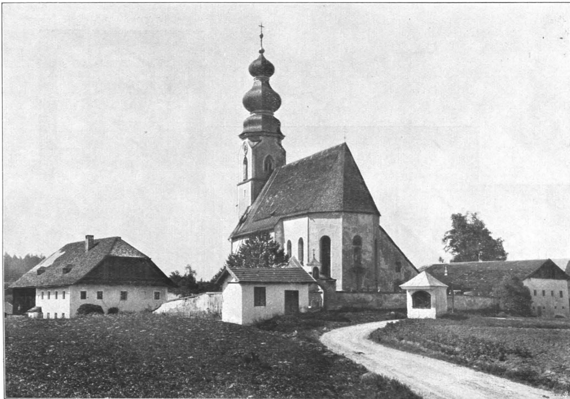
Fig. 50 Irrsdorf, Filialkirche, Ansicht von Südosten (S. 58)
